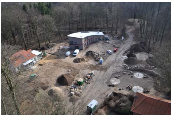
Blick auf die Baustelle vom Fernsehturm aus
