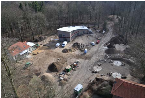
Blick auf die Baustelle vom Fernsehturm aus
