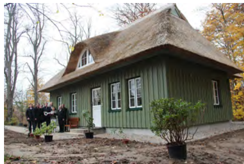
Schlüsselübergabe nach Fertigstellung
