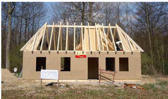
Ansicht des Rohbaus
