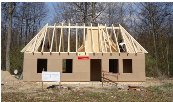
Ansicht des Rohbaus
