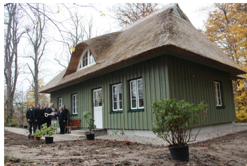
Schlüsselübergabe nach Fertigstellung
